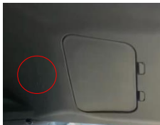
Fig. 4 – Área de inducción no eléctrica
